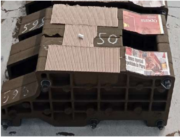
Fig. 2 – Shoted mould ready to pour
